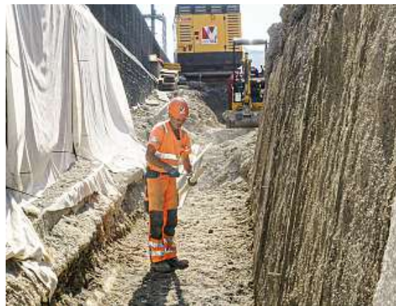
Baustelle an der Bruggerstrasse in Baden (Schellenacker), wo die Stützmauer errichtet wird
